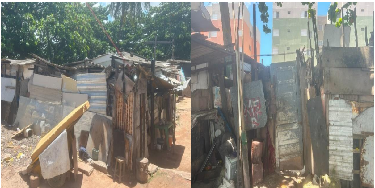
Fotografias 15 a 20 - Moradias das favelas da Comunidade do Dique Estrada.
