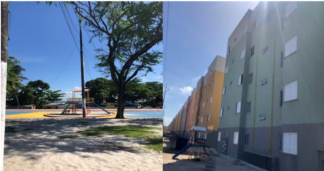
Legenda: Área de lazer com parques e apartamentos construídos com 4 pavimentos. Fonte: Autora, 2022.
