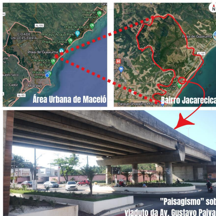
Figura 12 - Viaduto localizado na Av. Gustavo Paiva, em Jacarecica
