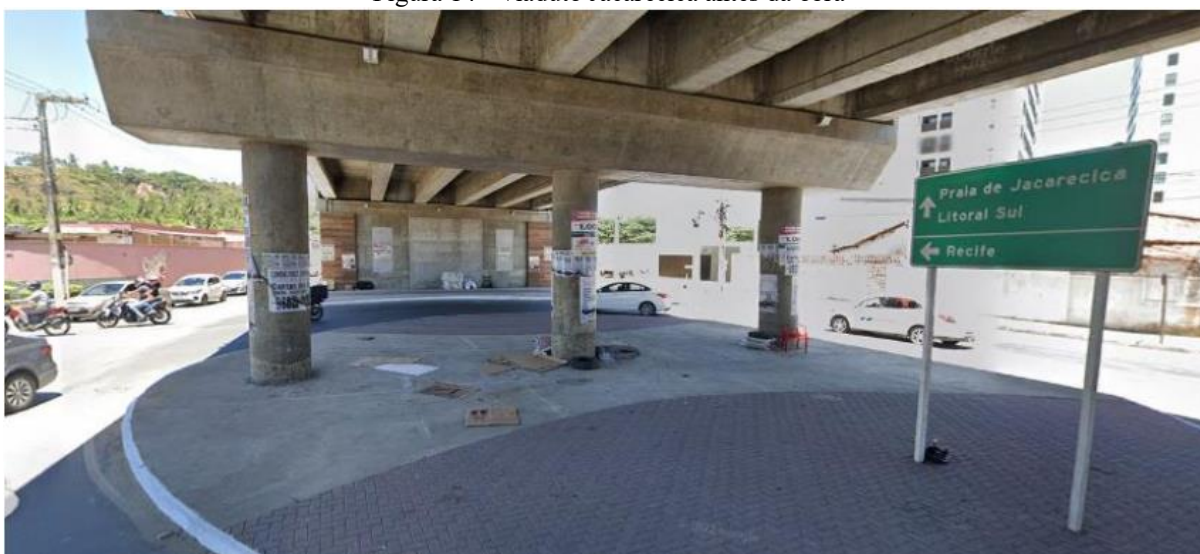
Figura 14 - Viaduto Jacarecica antes da obra
