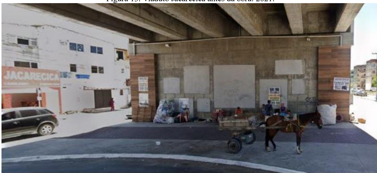
Figura 13. Viaduto Jacarecica antes da obra. 2021.
