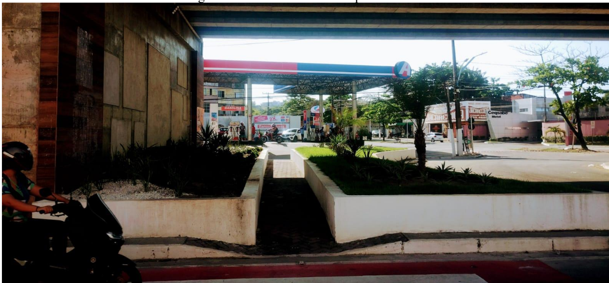
Figura 11 - Viaduto Jacarecica após a obra
