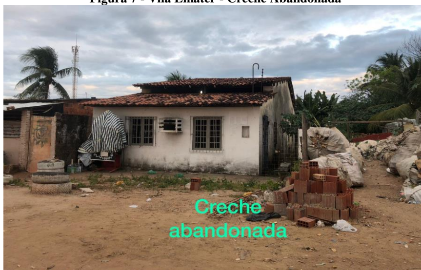
Figura 7 - Vila Emater - Creche Abandonada
