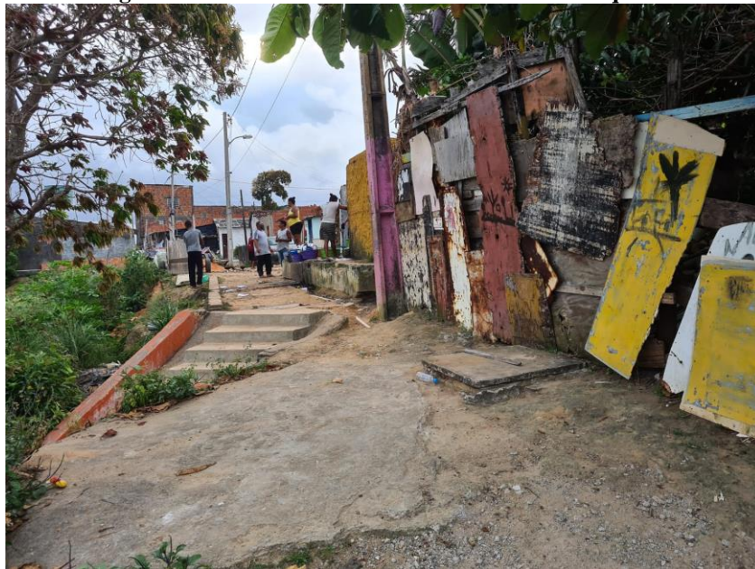
Figura 8 - Vila Emater - Ruas sem Estrutura Adequada
