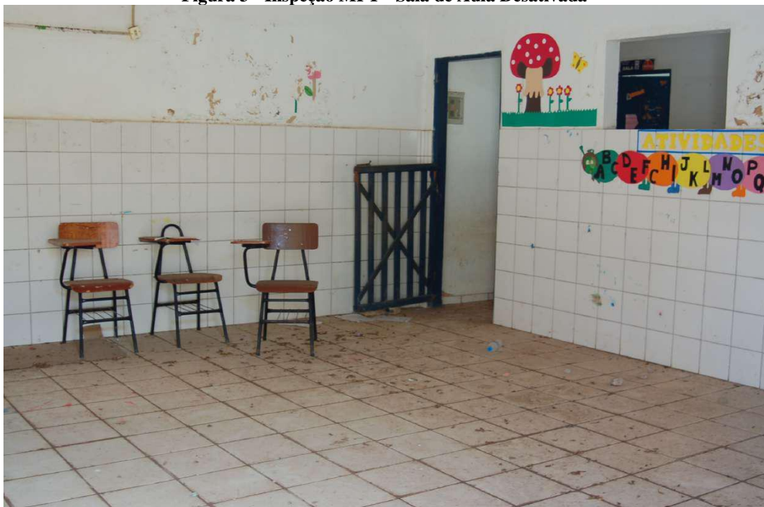
Figura 3 - Inspeção MPT - Sala de Aula Desativada
