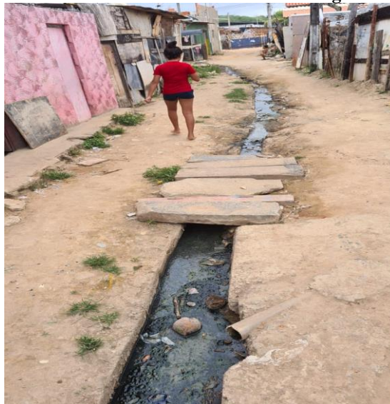
Figura 9 - Vila Emater - Falta de Saneamento e Esgoto a Céu Aberto
