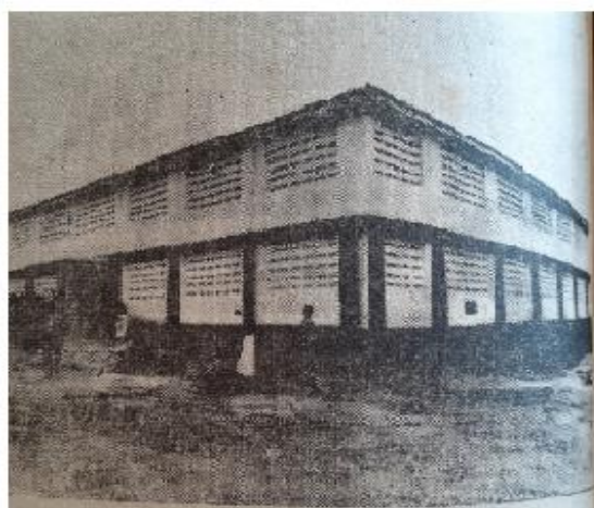
FIGURA 8 - Fachada do Instituto Penal Santa Luzia. Fonte: Diário Oficial de Alagoas de 11 de março de 1975.
